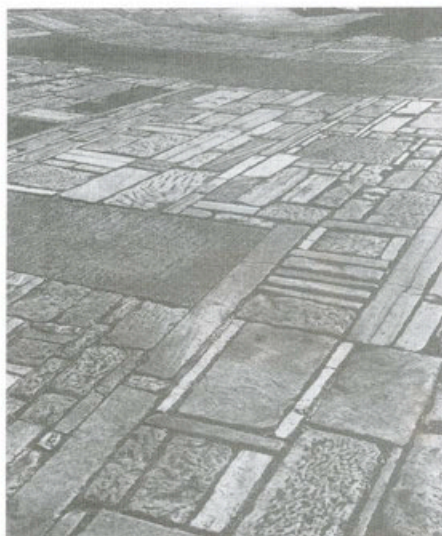
Εικ.3.26 Η πλακόστρωση στην είσοδο της Ακρόπολης, έργο του αρχιτέκτονα Δ. Πικιώνη (1964). Στο έργο συνδυάζονται ορθογωνικές πλάκες μαρμάρου με διάφορες διαστάσεις.
