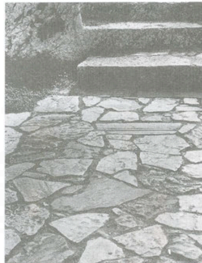
Εικ.3.27 Πλακόστρωση με μη κανονικές πλάκες στη διαμόρφωση γύρω από την Ακρόπολη, έργο του αρχιτέκτονα Δ. Πικιώνη
