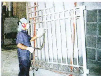
Σχήμα 12.4α. Επιμετάλλωση με πιστόλι
