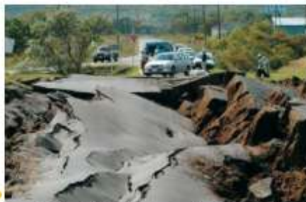
Εικόνα 16.2: Καταστροφή από σεισμό
