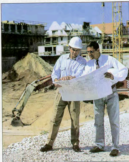
Εικ. 6.5. Εκσκαφές για θεμελίωση κτιρίου.
