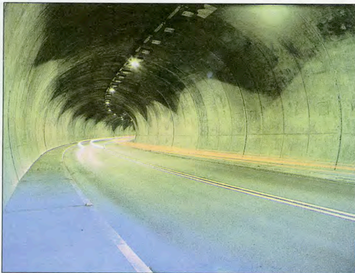
Εικ.6.3. Σύραγγα (τούνελ) αυτοκινητοδρόμου.
