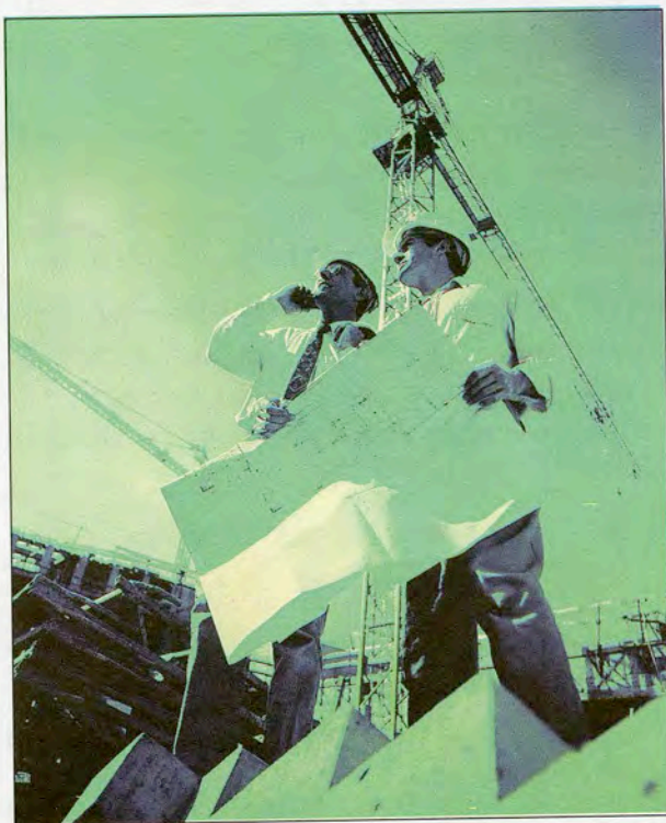
Εικ. 6.14. Εφαρμογή των σχεδίων μελέτης στην πράξη για την πραγματοποίηση της κατασκευής.
