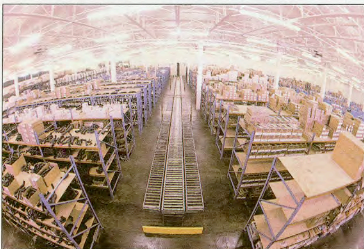
Εικ. 6.11. Βιομηχανικός χώρος με οροφή με μεγάλα ανοίγματα χωρίς ενδιάμεσες στηρίξεις για αποθήκευση εξαρτημάτων παραγωγής αυτοκινήτων.
