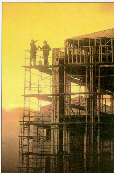
Εικ. 6.1. Σκαλωσιά για την κατασκευή του σκελετού που θα φέρει τα φορτία στο κτίριο που κατασκευάζεται.
