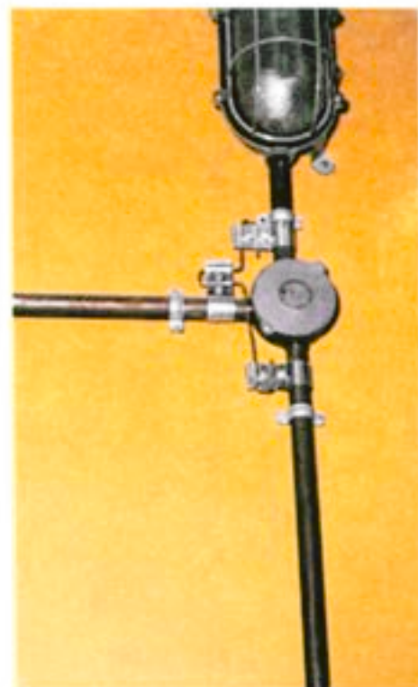
Σχήμα 2.2.3α: Ορατή εγκατάσταση με ευθύγραμμους χαλυβδοσωλήνες
