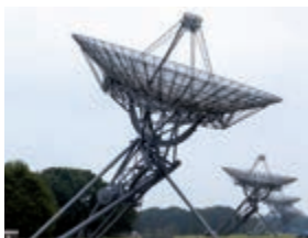
Εικόνα 2.12 Επίγειος σταθμός λήψης τηλεπικοινωνιακού δορυφόρου
